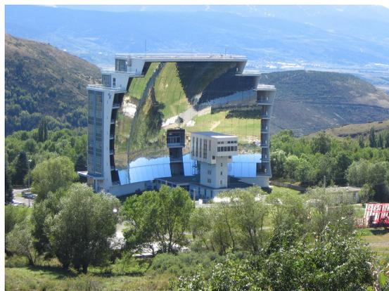
FIGURE 1.1 – Le four solaire d'Odeillo, à Font Romeu, d'une puissance d'1 MegaWatt, est l'un des plus grand du monde.
